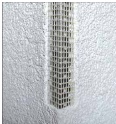
Detail umístění kombi lišty - řez
