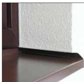
Foto realizace připojovacího profilu HPI - UNI
