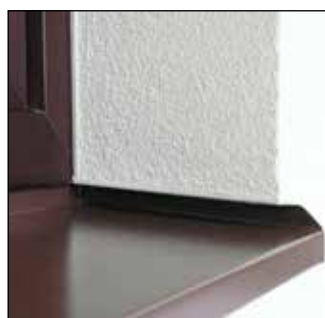
Foto realizace připojovacího profilu HPI - UNI
